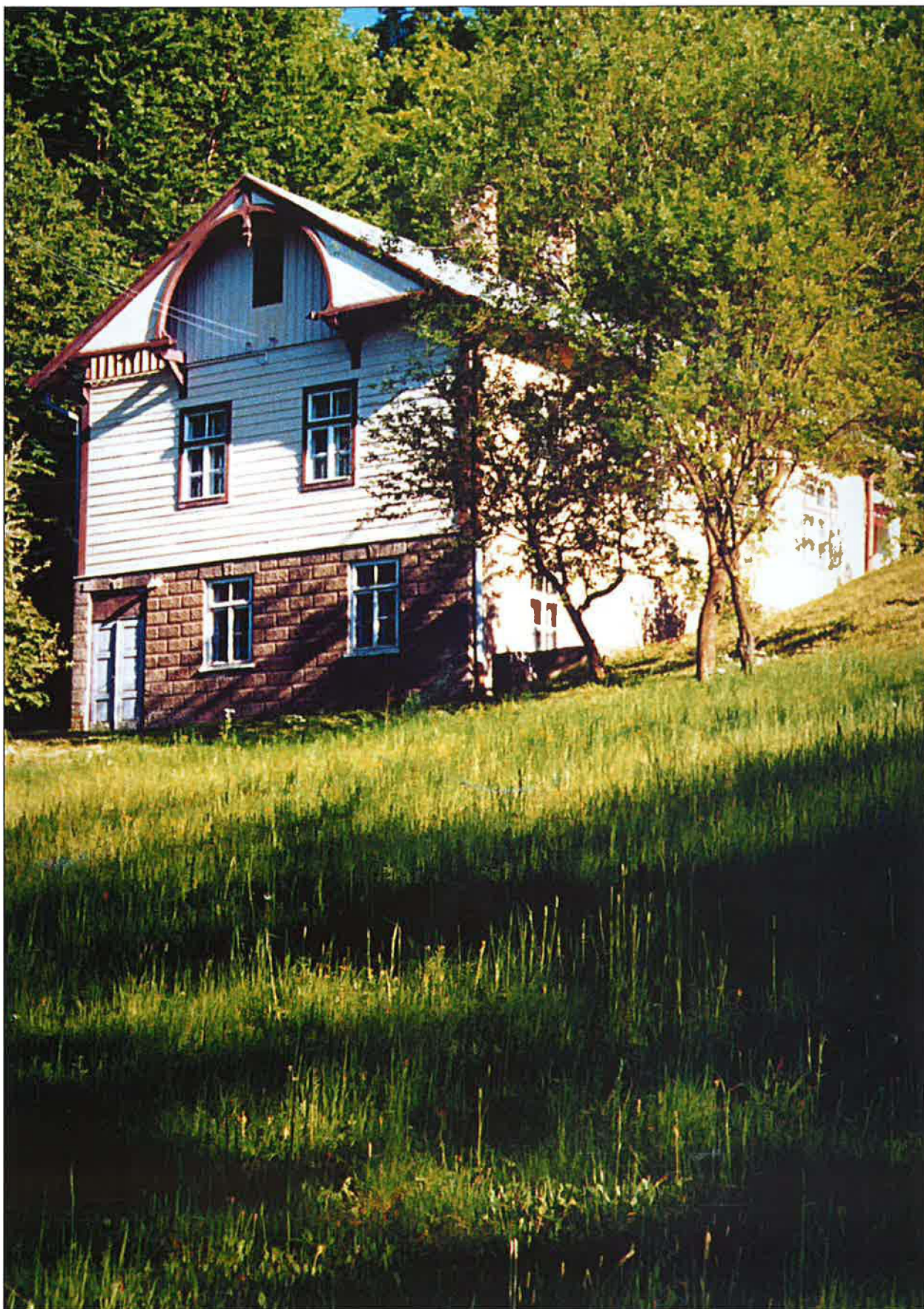
Jeden z budynków dawnej „Kolonii Lwowskiej” (z końca XIX w.), obecnie szkoła Domu Wczasów Dziecięcych. Fot. Jerzy Wygoda.
