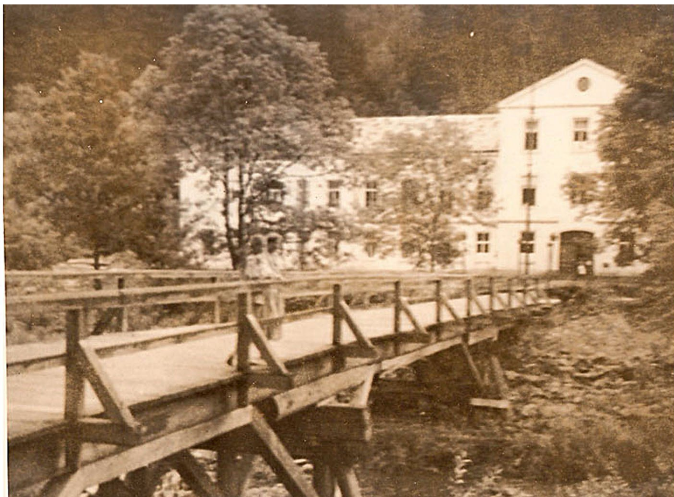
10. Zdjęcie: widok na Lazienki od strony mostu – kładki na rzece Tabor.
