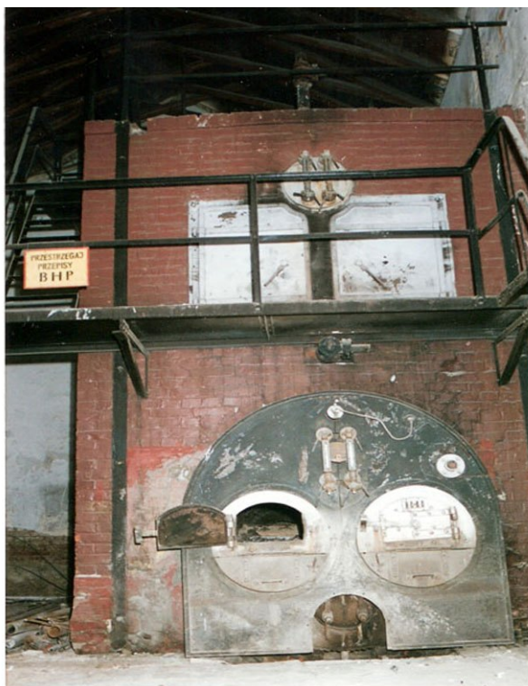
11. Zdjęcie powojenne kotła Tischbein tuż przed likwidacją i rozbiórką.
