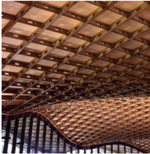
1. Przykład konstrukcji rusztowo-powłokowej pawilonu w Savil Garden, proj. Glen Howells Architects, 2005-2006.
