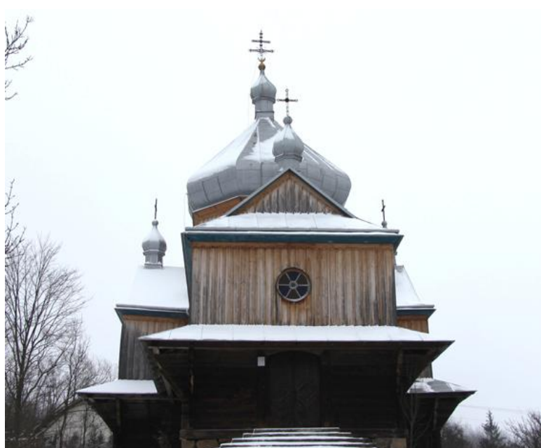
14. Widok elewacji z wejściem.
