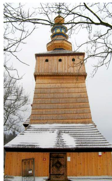
10. Widok elewacji z wejściem.
