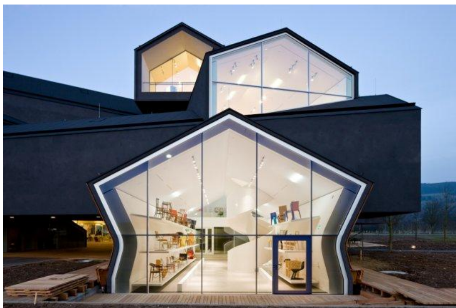
31. VitraHaus, Weil, proj. Herzog & De Meuron. Widok brył.
