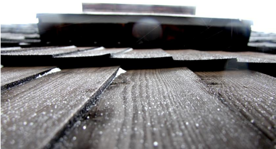
6. Cerkiew w Chyrowej. Układ gontów na elewacji.
