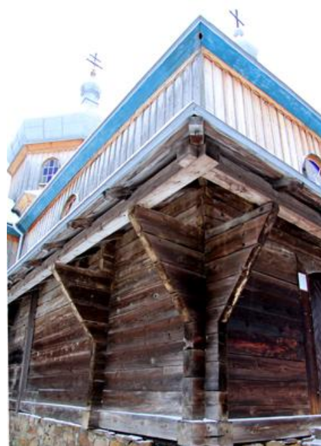
12. Układ belek drewnianych.
